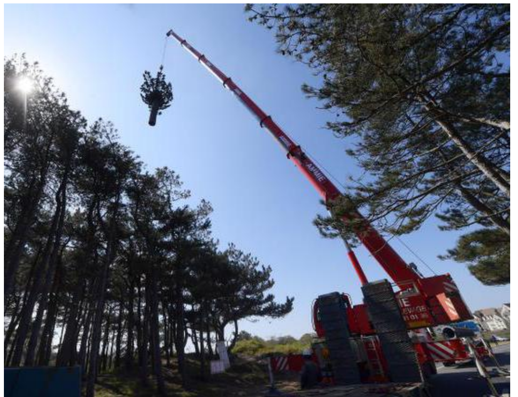
Le pylône est assemblé en plusieurs parties grâce à une grue de 100 tonnes.
