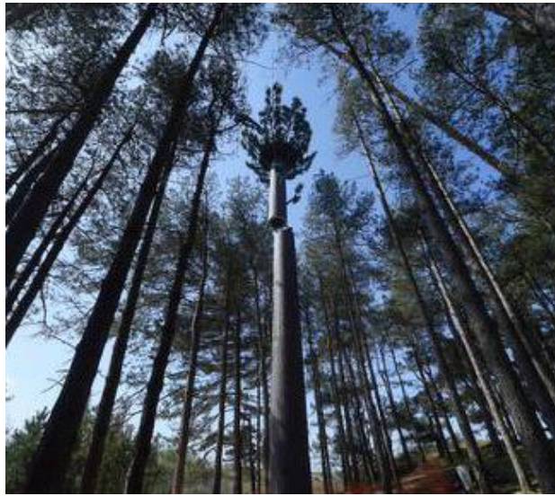
Pas moins de 36 vis retiennent le pylône dans la dalle de béton
