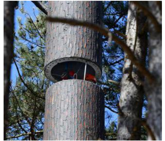
Le pylône pèse 11 tonnes.
